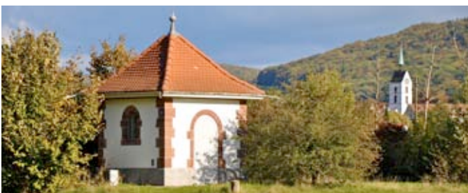
Sechs dieser kleinen Häuschen stehen auf Riehener Boden: Es sind Grundwasserbrunnen.
