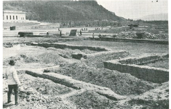
Beim Bau des Friedhofs Hörnli kamen römische Mauern zum Vorschein. Hier stand vermutlich ein grosser Hof mit Säulenumgang und Getreidespeicher.
