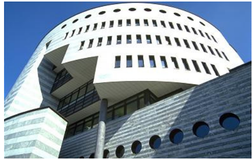
Abb. 1: Gebäude von Mario Botta in Basel. Quelle: http://www.basel.ch , 30.5.04
