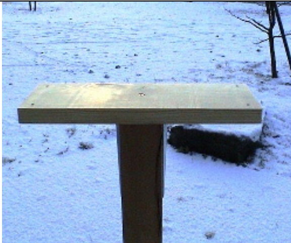
11. Montagevorschlag auf Holzpfosten. Trägerbrett von oben geschraubt und mit Metallwinkeln verstärkt.
