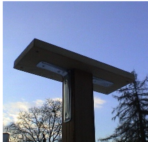
11. Montagevorschlag auf Holzpfosten. Trägerbrett von oben geschraubt und mit Metallwinkeln verstärkt.
