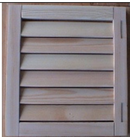
Türe von innen, mit Ausfräsungen für Scharniere
